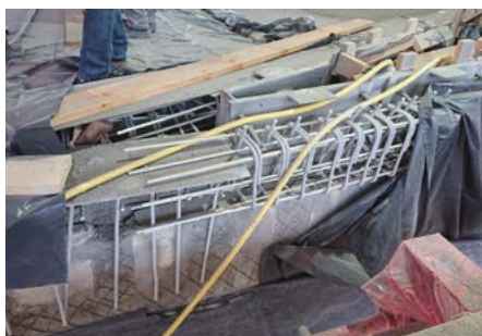
Im Dachbereich wurden im Twist Randbalken ausgebildet. Für die sichere Lastabtragung sorgt auch hier Schöck Combar in Form von Bewehrungskörben.
