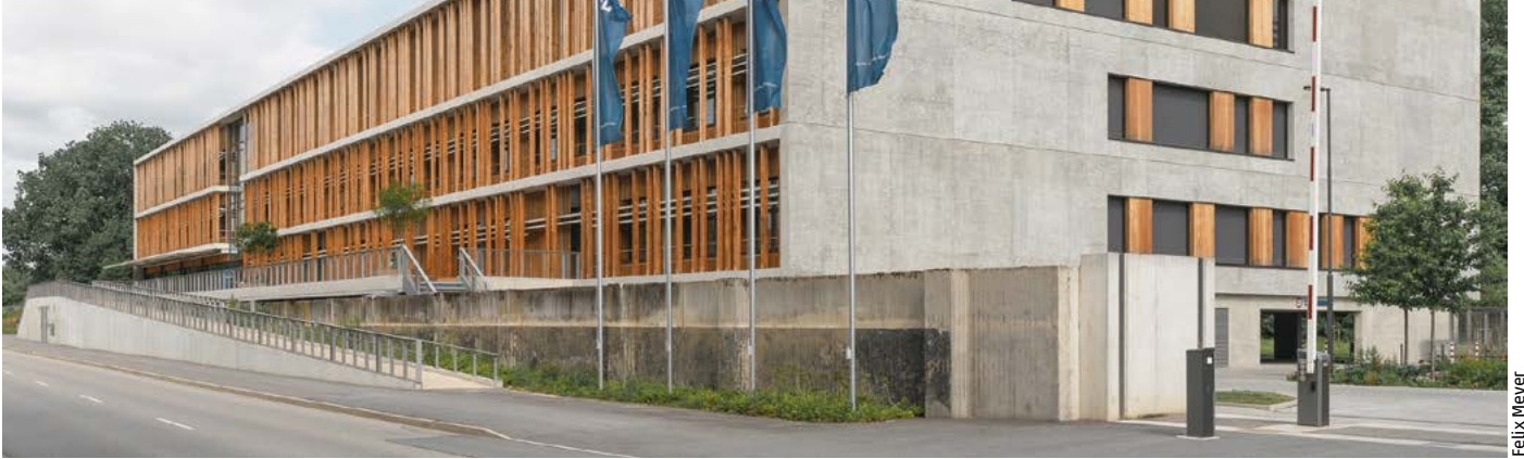
Abb. 1: Das Hörsaal- und Forschungsgebäude für Nachhaltige Chemie der TU München in Straubing. Im Vordergrund sind das Zugangsbauwerk und die Hochwasserschutzwand (Bestand) zu sehen.
