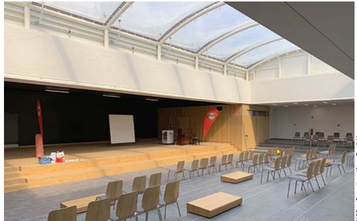
Eine Membrankonstruktion überdacht das Atrium der Schulaula.
