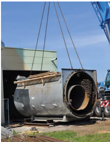
Dekarbonisierung in Kamenz: Demontage des 80 Tonnen schweren Braunkohlebrennstaubkessels.
