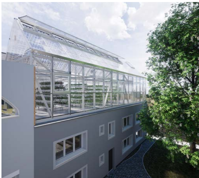
Die Abwärme der unter dem Gewächshaus liegenden Wohnungen deckt einen Teil der benötigten Wärmelast ab. Bild: TH Köln
