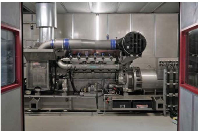
Zuständig für nachhaltige Strom- und Wärmeversorgung in Kamenz: eines von vier wärmegeführten BHKW mit einem Megawatt elektrischer Leistung und 1060 Kilowatt thermischer Leistung.
