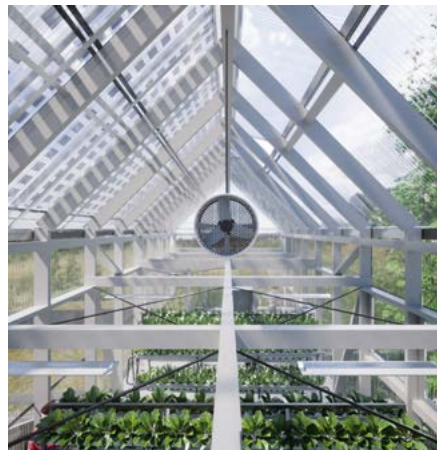
Ein Ventilator sorgt für gleichmäßige Temperatur und Luftfeuchte im Haus. Bild: TH Köln
