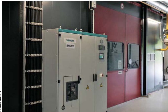
Hier kann auch manuell geregelt werden: Steuerschrank von BHKW 1 im Heizkraftwerk in Kamenz.
