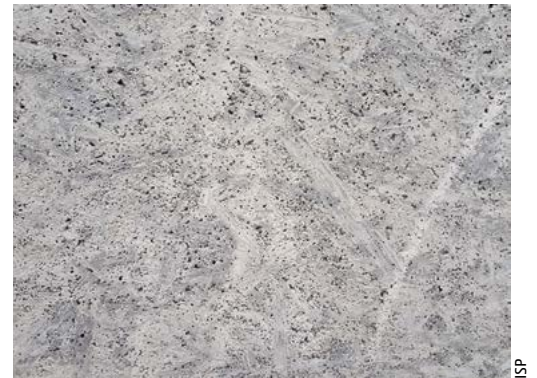
Abb. 12: Detailansicht der Infraleichtbeton-Oberfläche
