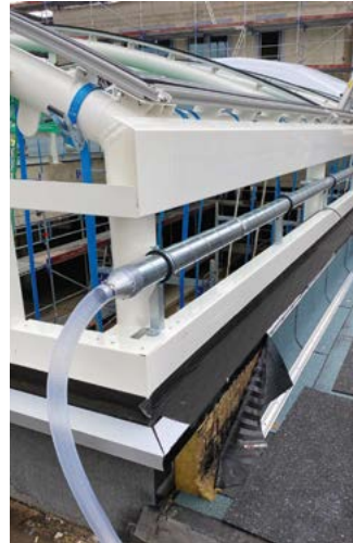
Die Luftversorgung für das Membrandach erfolgt über eine Luftstützanlage mit entfeuchteter Luft.
