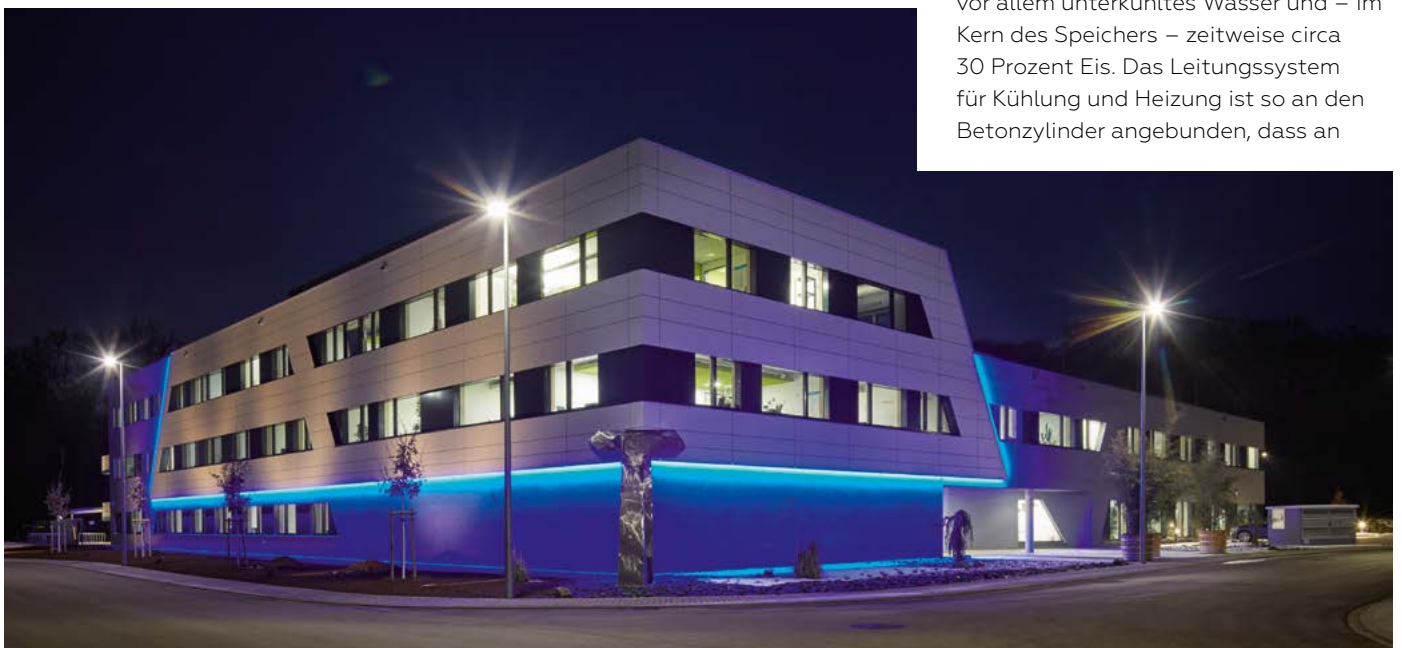
Im ersten Bauabschnitt entstand 2016 ein hocheffizientes Büropassivhaus für die Software-Manufaktur TUP in Stutensee bei Karlsruhe. Dank Eis-Latentwärmespeichertechnologie ist das Gebäude nahezu energieautark. Bild: Vollack Gruppe
