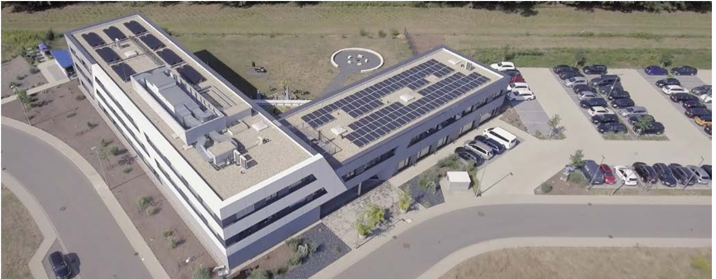
Auf dem Dach des TUP-Büropassivhauses ist eine 40-Kilowatt-Peak-Photovoltaik-Anlage installiert. Die gewonnene Solarenergie wird für das Heizen und Kühlen des Gebäudes genutzt. Bild: Vollack Gruppe
