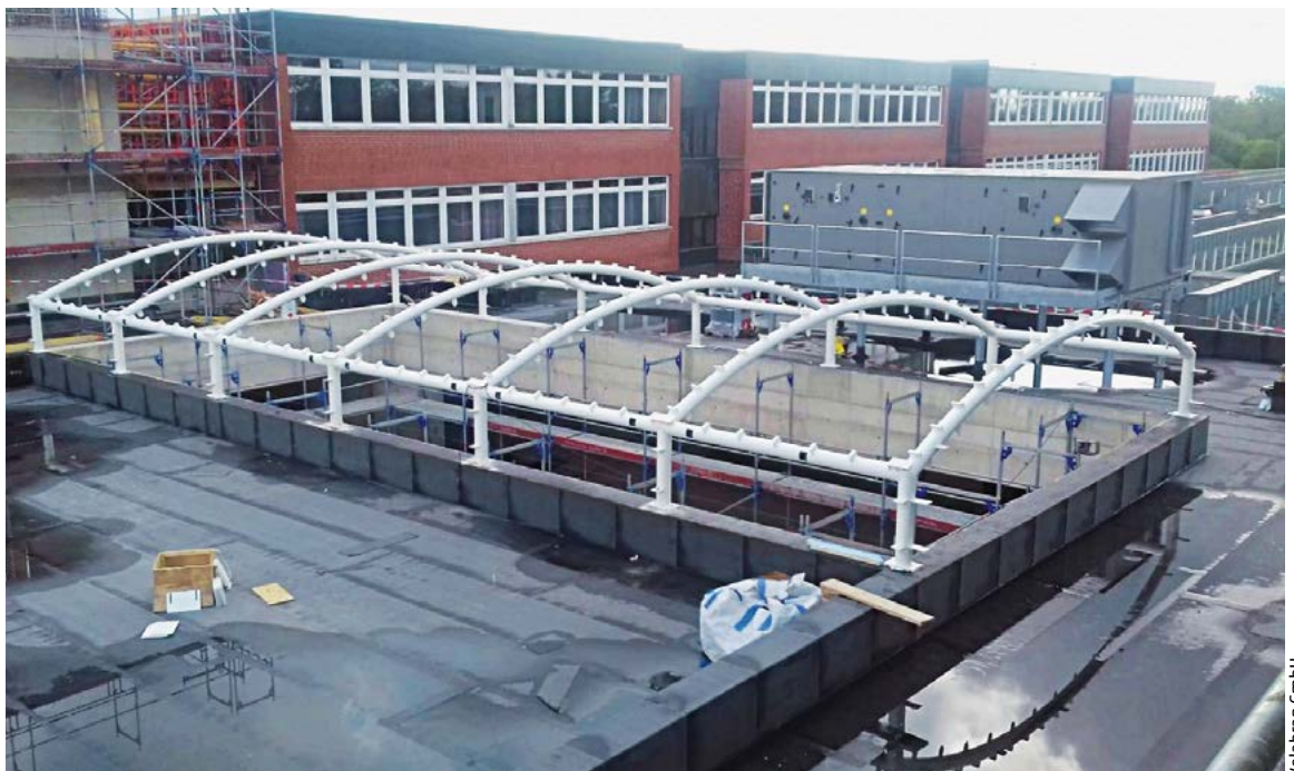
Der Aufbau des Membrandachs.
