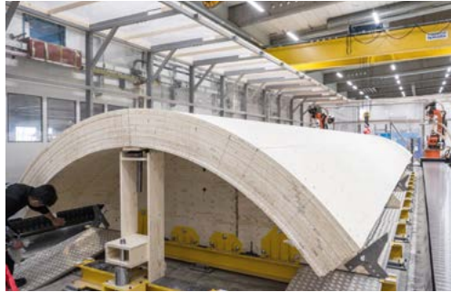
Modvion setzt beim Bau der Windkraftanlagen auf Holz. Bild: Modvion
