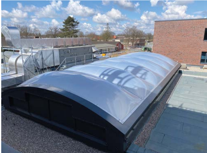
Das Membrandach von oben.
