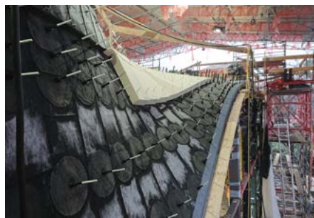
Für das energieeffiziente Dach sorgen die 14 Zentimeter Wärmedämmung sowie der Fassadenanker Schöck Isolink, der Wärmebrücken minimiert.
