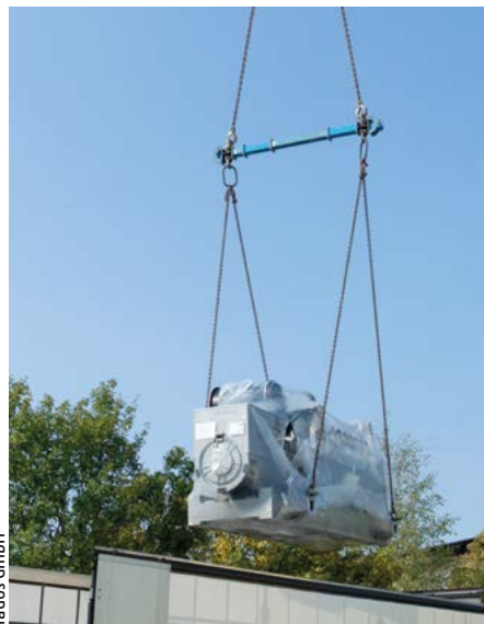
Anlieferung eines BHKW für das Heizkraftwerk am Standort Friedensstraße zur nachhaltigen Versorgung über Kraft-Wärme-Kopplungsverfahren in Kamenz.
