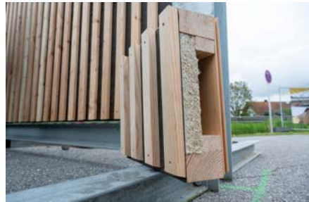
Nachhaltige Lärmschutzwand mit Canwool-Inlays aus Hanf. Bild: Armin Weigel/Rau.de
