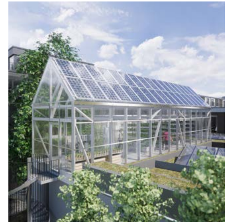
Das Konstruktionsvollholz hat einen feuchtebeständigen weißen Anstrich. Bild: TH Köln
