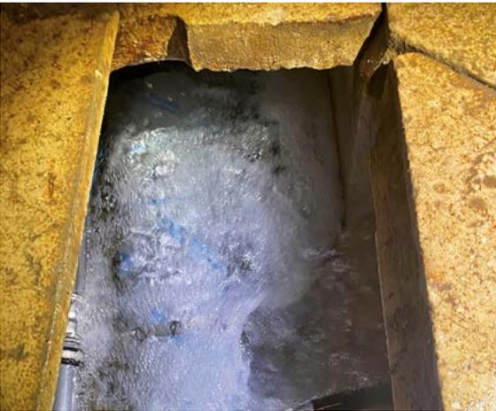
Die Kühlenergie kommt aus dem unterirdischen Grabenbach, einem Nebenfluss der Saalach. Er wurde in der ersten Hälfte des 16. Jahrhunderts angelegt, um Süßwasser aus der Saline abzuleiten und so eine Verwässerung der Solequellen zu verhindern.
