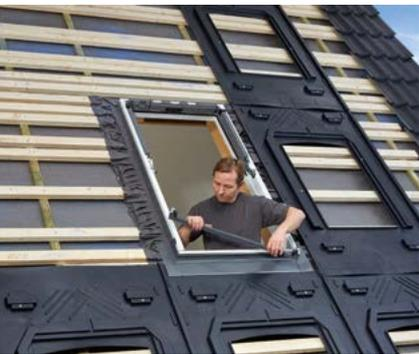
helfen Produkte von Velux: Die Eindeckrahmen „ODL“ und „ODN“ wurden dafür entwickelt, Velux Fenster mit einer Vielzahl von Indach-PV-Modulen unterschiedlicher Hersteller verbinden zu können.
