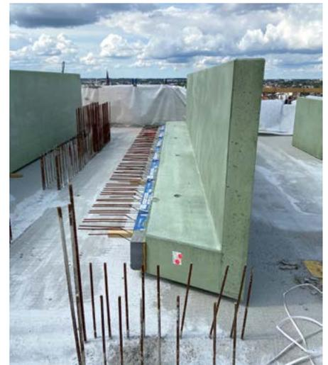
Die grün eingefärbten Brüstungselemente aus Beton wurden vorgefertigt auf der Baustelle angeliefert. Auch die tragenden Wärmedämmelemente Isokorb von Schöck waren bereits eingebaut. Foto: Schöck Bauteile GmbH
