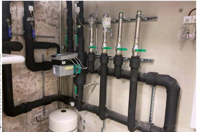
Die einzelnen Kühlkreise werden überwacht, die Pumpen entsprechend angesteuert.
