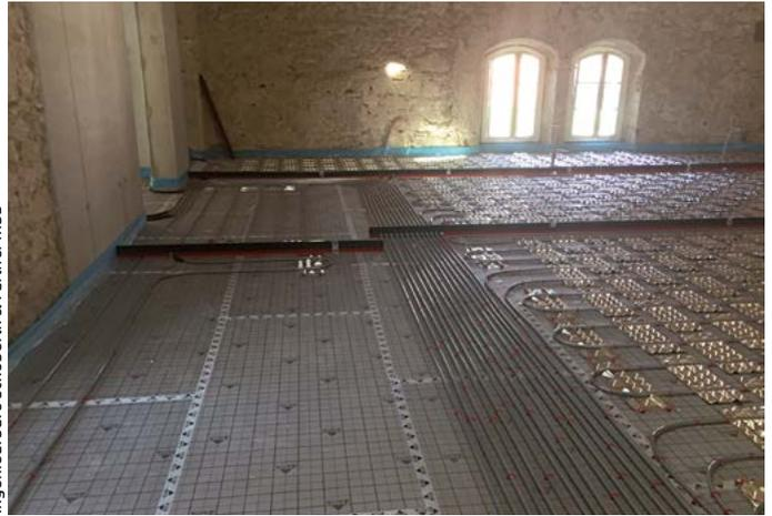
Die Wärmeleitbleche des Fußbodenheizsystems erlauben eine optimale Wärmeverteilung.
