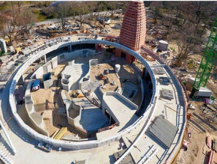
Die Berliner Nashörner erhalten ein rundes Gehege mit 52 Metern Durchmesser, in dem sogar im neuen Wasserbecken alle Stufen perfekt auf die Schrittgröße der Panzernashörner zugeschnitten wurden, wofür die Schalungskörper angepasst wurden (Bild: Zoo Berlin).
