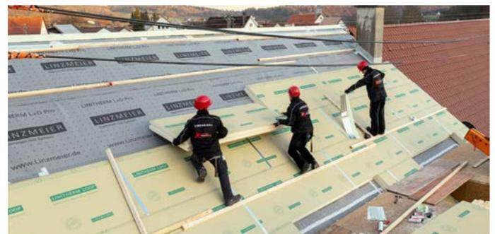
Aufsparrendämmung Linitherm Loop PAL N+F Bild: Linzmeier
