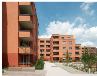
Die massive Außenwandkonstruktion der Neubauten wurde mit hoch wärmedämmenden perlitgefüllten Ziegeln Poroton-S9 von Schlagmann Poroton realisiert. Bild: Pk. Odessa Co / Lanz
