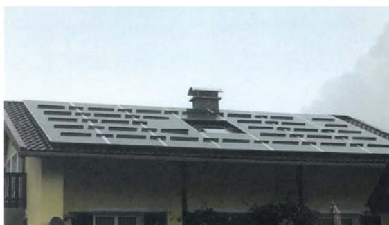
Abb. 3: Schneefangsystem auf Dach mit PV-Anlage in den bayerischen Alpen
