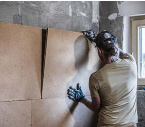
Im Holzbau dienen Lehmplatten für den Innenausbau unter anderem der Feuchtigkeitsregulierung.
