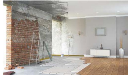
Mit den Estrich Elementen fermacell Therm25 von James Hardie gelingt das Umrüsten auf Fußbodenheizung auch im Bestandsbau mit relativ geringem Aufwand. Bild: James Hardie Europe GmbH
